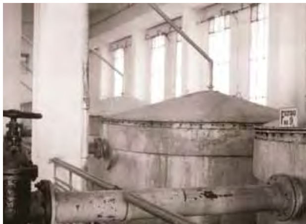
Filtre închise tip Bollman – Uzina de apă nr. 2
