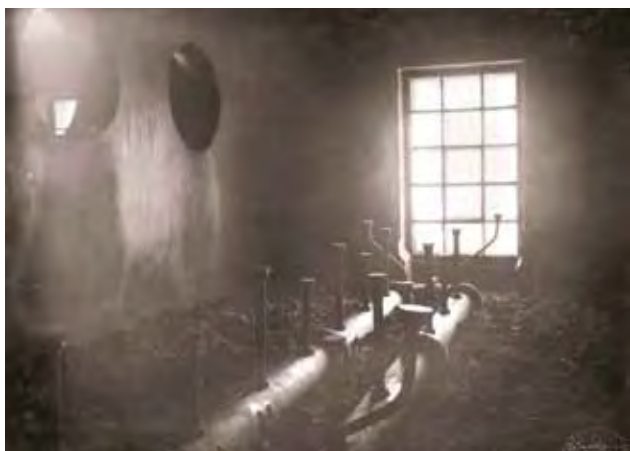
Cameră de pulverizare – Uzina de apă nr. 1
