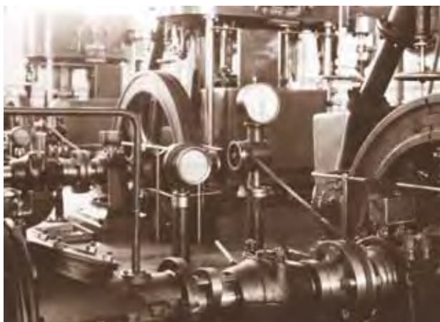
Sala mașinilor – Stația de epurare
