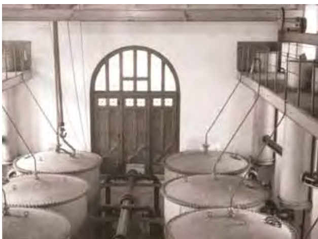
Filtre închise tip Bollman – Uzina de apă nr. 1
