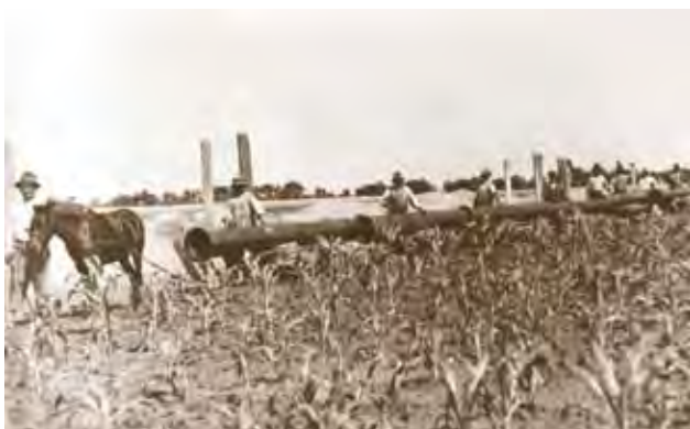
Lucrări pentru execuția rețelei de apă, 1914
