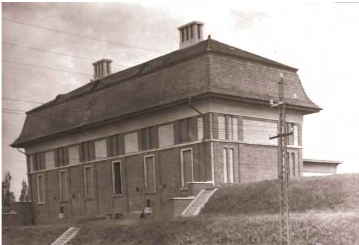
Clădirea deferuginatorului – Uzina de apă nr. 1
