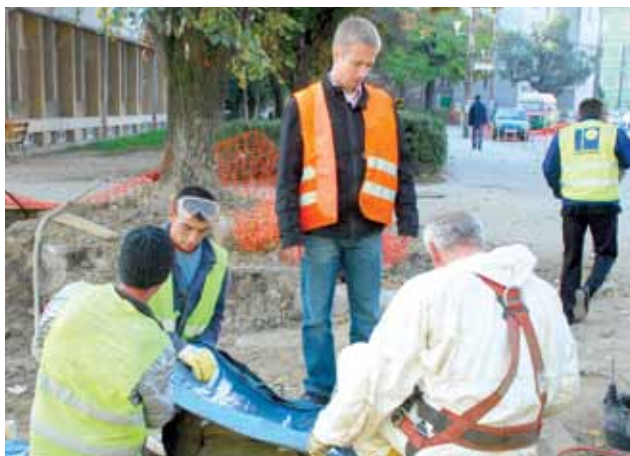
În premieră, la Timișoara, reabilitarea conductelor de canalizare prin cămășuire
