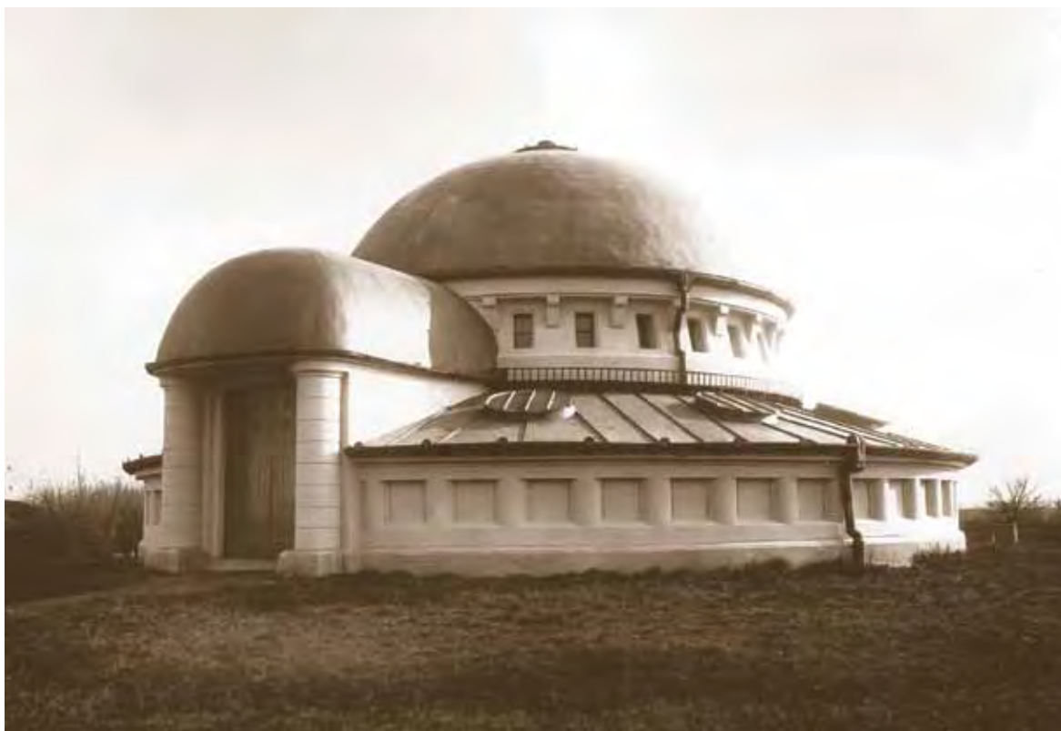
Clădire ce adăpostește un grup de foraje, 1914
