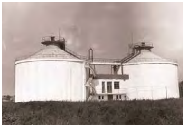
Metantancuri, Stația de epurare
