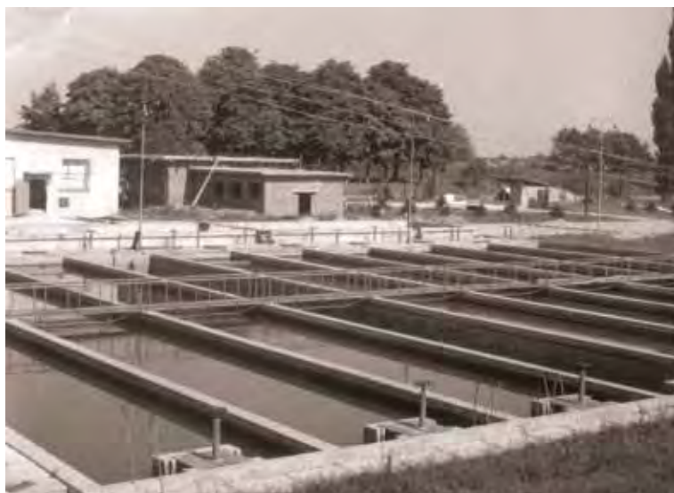
Bazine de decantare – Uzina de apă nr. 2
