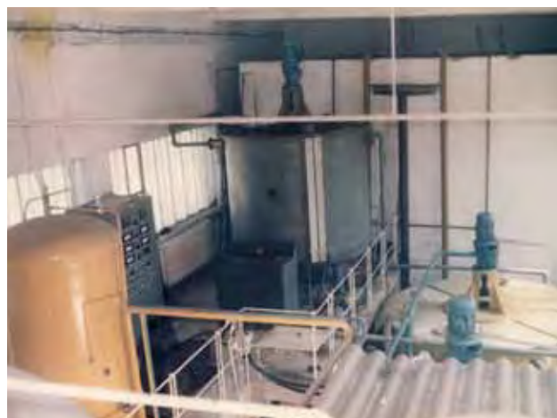
Stația de silicat de sodiu – Uzina de apă nr. 2-4
