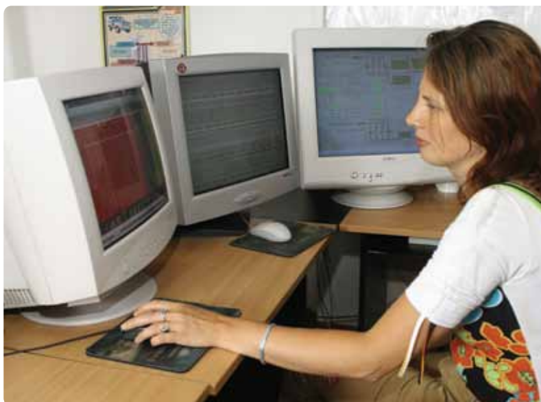
Control automat al proceselor, la stația de tratare Bega
